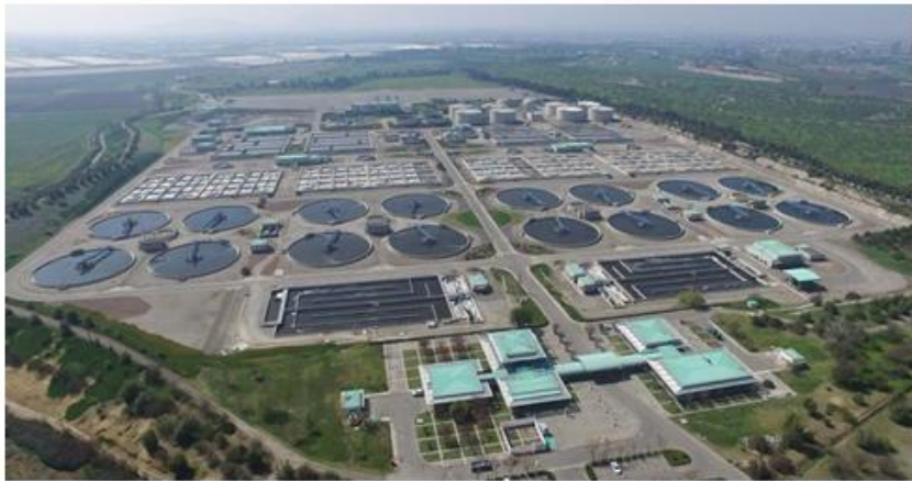
Planta Depuradora La Farfana desde 2003
